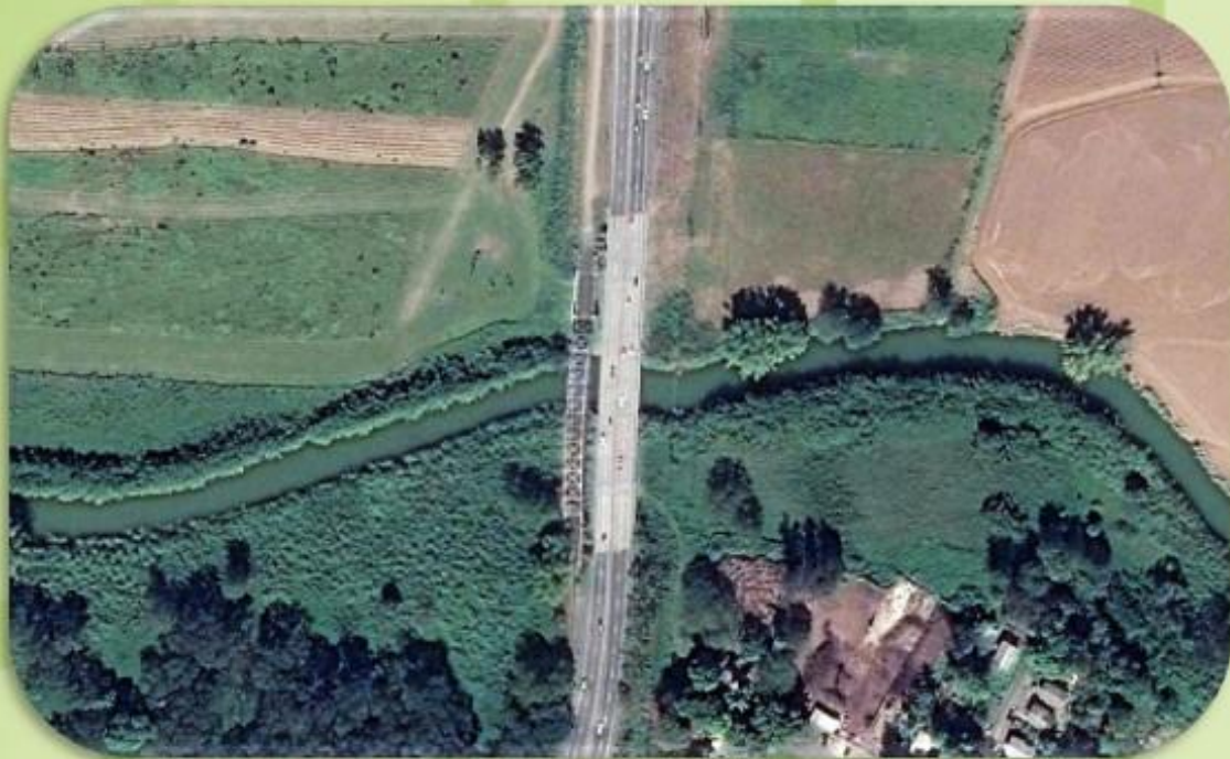
BRIDGE OVER "RIO GRANDE DE AÑASCO"
