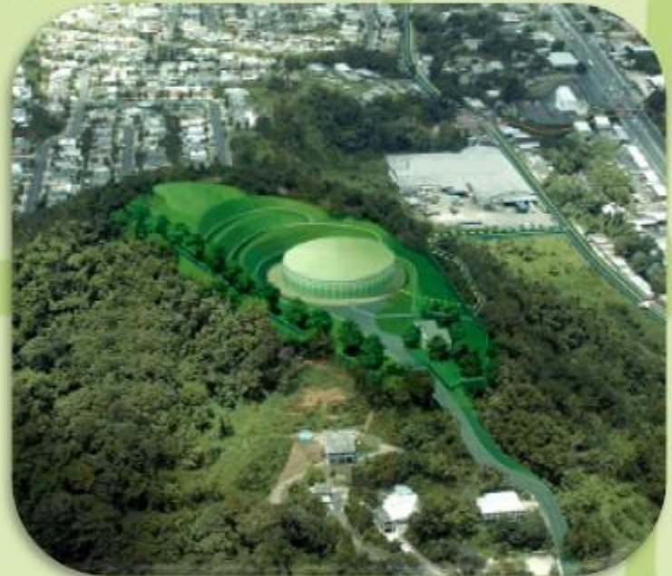
LA PONDEROSA 5 M.G. WATER TANK, CAGUAS, P.R.
